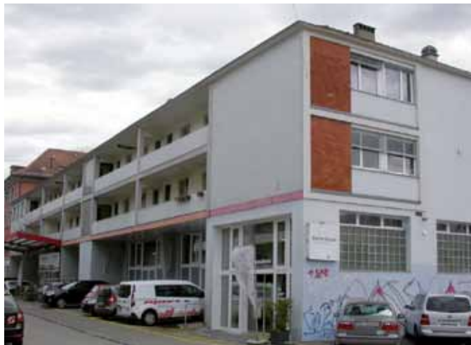
Am Hofweg 5: Zwecks Totalrenovation wurden allen MieterInnen der Wohnungen gekündigt.
