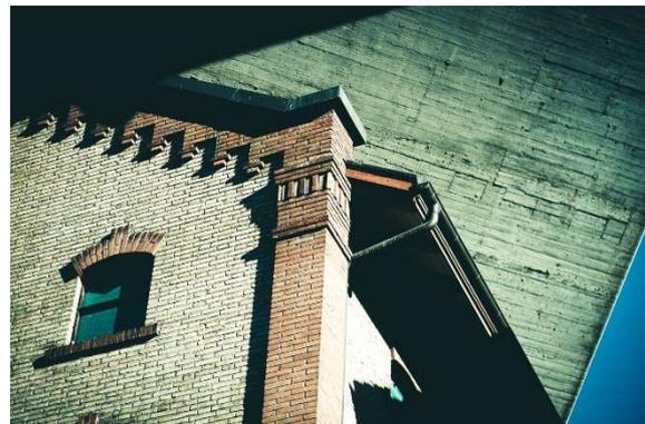
Abb. 25 Detail des Blendgiebels mit Ecklisene am Sudhaus
