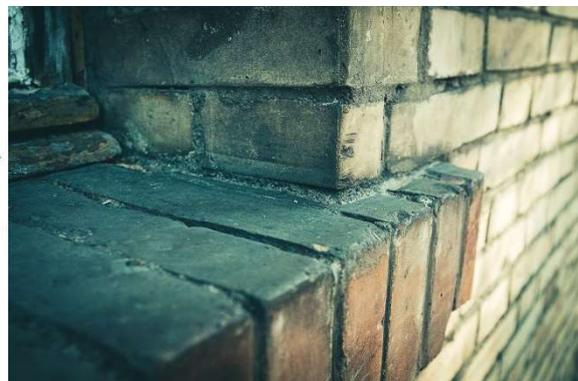
Abb. 37 Detail Rollschicht Fensterbank
