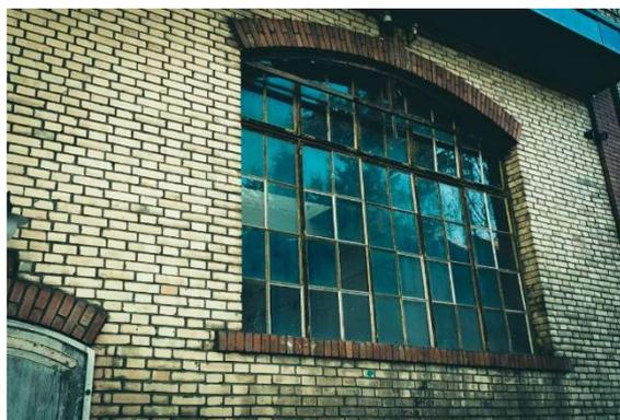
Abb. 59 Metallfenster im Eisfabrikationsraum
